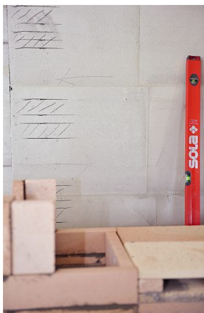
Für den Ofenbau unerlässlich: skizzierte Position des Ofens, gezielte Mörtelarbeit und geeignetes Werkzeug.
